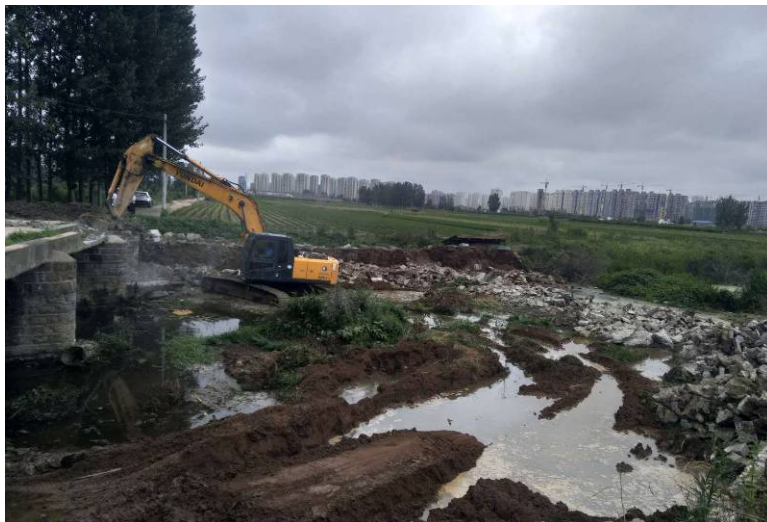
7月7日进展情况（拆除陡沟桥）
