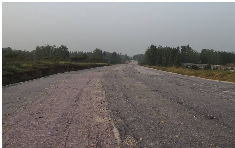
9月25日进展情况 国道以北段水稳二层已铺设3.7千米。
