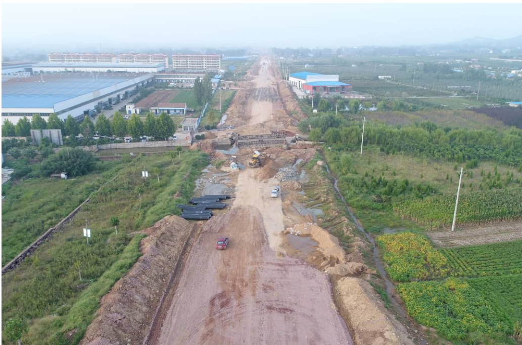
9月25日进展情况 正在进行边沟开挖、路基及部分桥梁施工。
