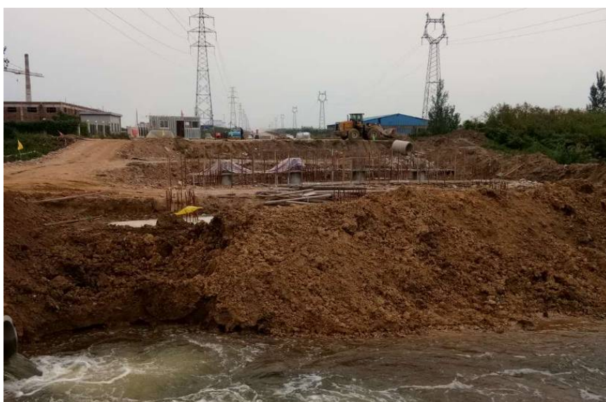
9月25日进展情况 正在进行跨牛腿沟桥梁施工。
