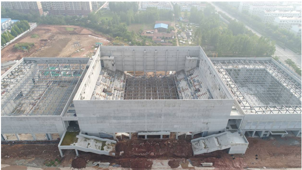
9月25日进展情况 正在进行训练馆外墙、比赛馆内墙、游泳馆内墙粉刷。
