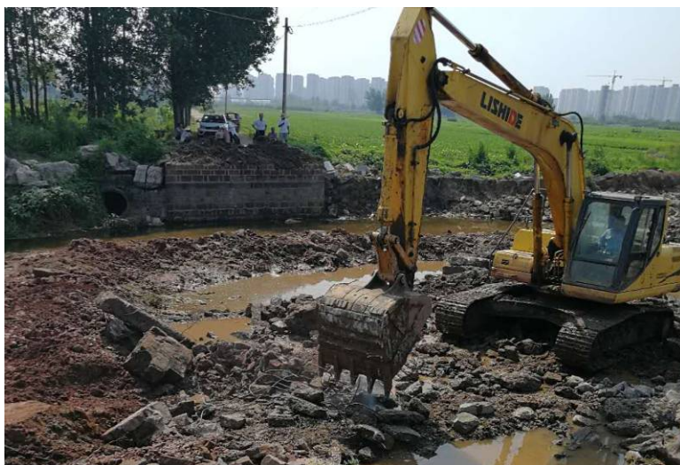
7月20日进展情况（新陡沟桥基础开挖）
