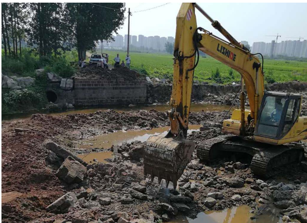
7月20日进展情况（新陡沟桥基础开挖） 该工程已于7月7日开工建设
