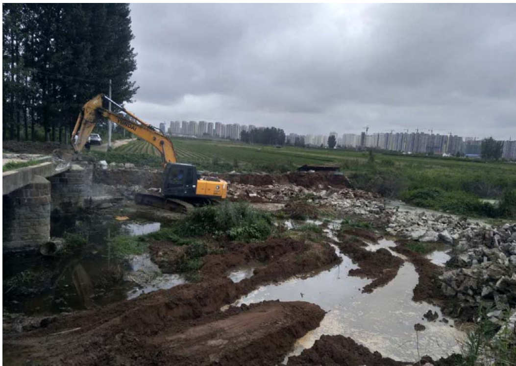
7月7日进展情况（拆除陡沟桥）
