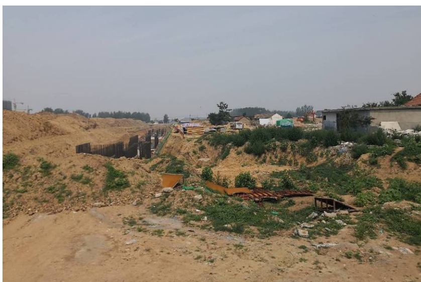
6月20日进展情况 (已于4月10日进场施工)
