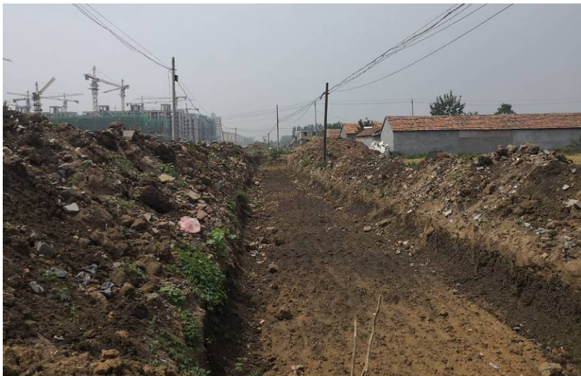
6月20日进展情况 (已于4月15日进场施工)
