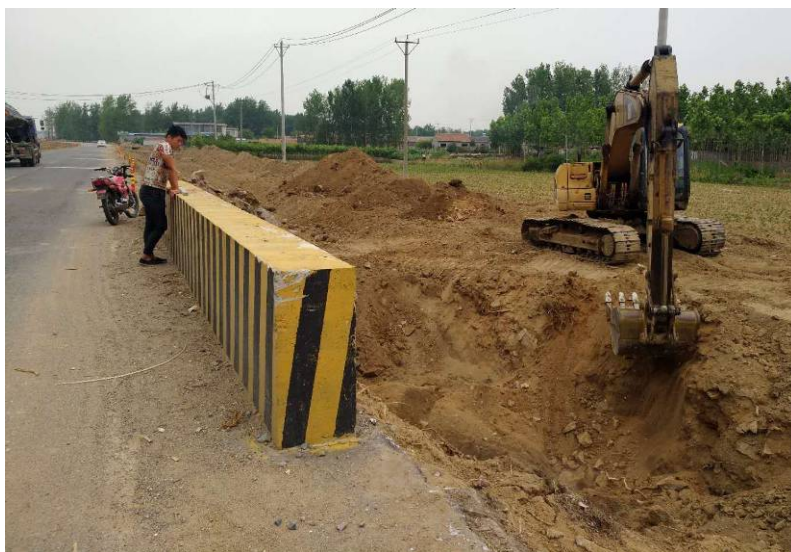
6月20日进展情况 (已于6月10日开工建设)
