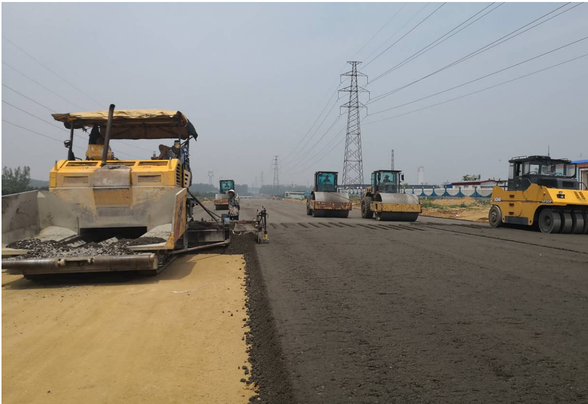
6月20日进展情况 (已于6月18日开工建设)
